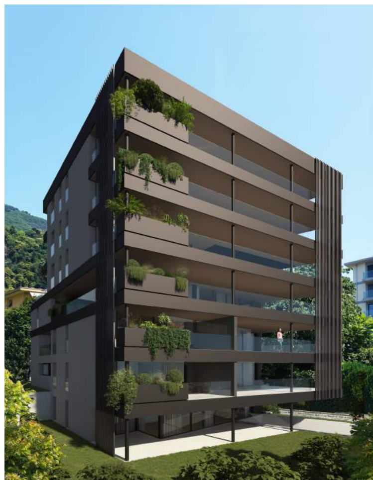
Vista 01 - Facciata Sud - Ovest
